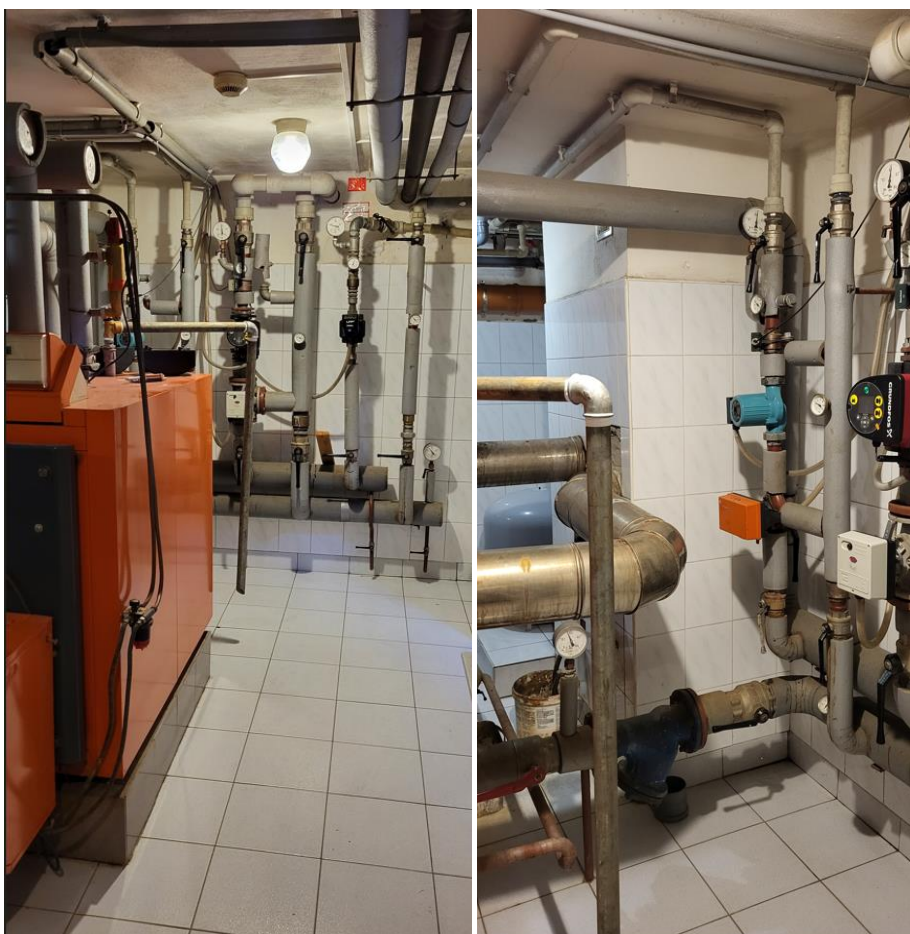
Fot. nr 10,11 Widok rozdzielacza wraz z grupami pompowymi. Źródło własne.
