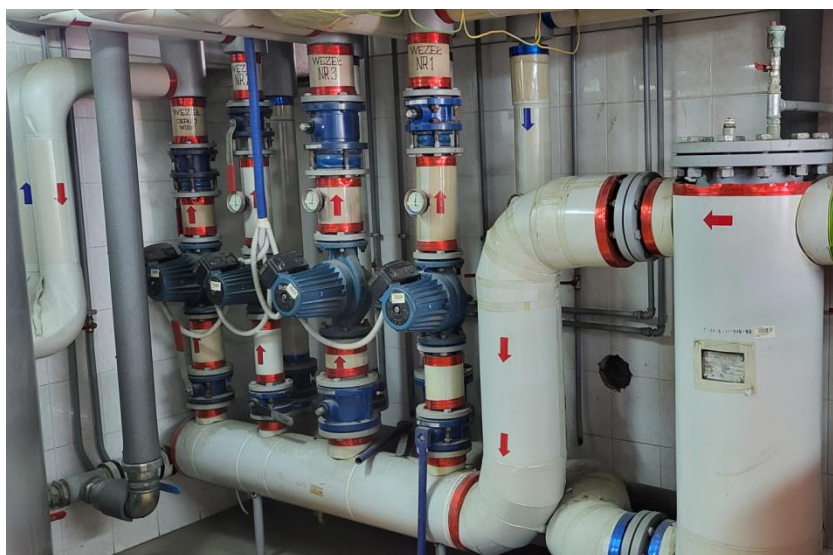
Fot. nr 17 Widok rozdzielacza hydraulicznego. Źródło własne.
