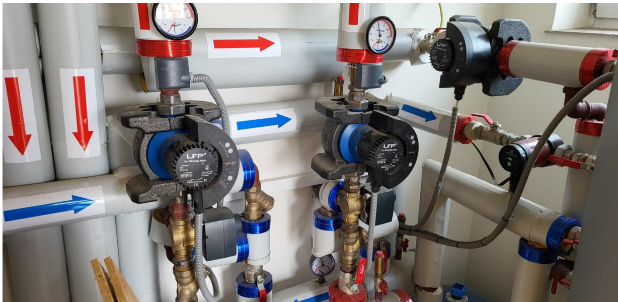
Fot. nr 6 Widok rozdzielacz instalacyjny wraz z obiegami grzewczymi. Źródło własne.
