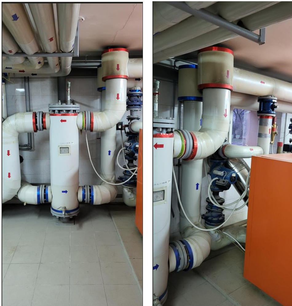
Fot. nr 15,16 Widok sprzęgła hydraulicznego oraz przyłączy kotłów. Źródło własne.
