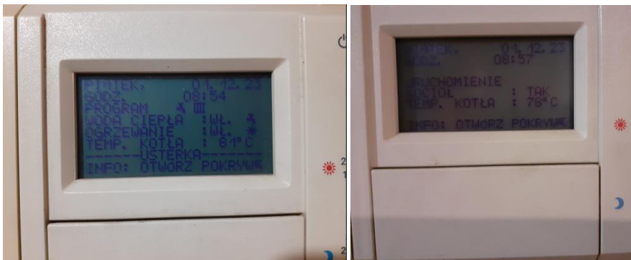
Fot. nr 8,9 Widok paneli sterowniczych Dekamatik kotła Duplex oraz Simplex. Źródło własne.
