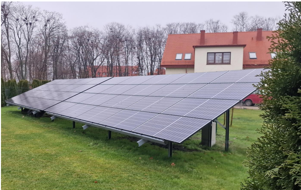
Fot. nr 20 Widok posadowienia instalacji PV. Źródło własne.
