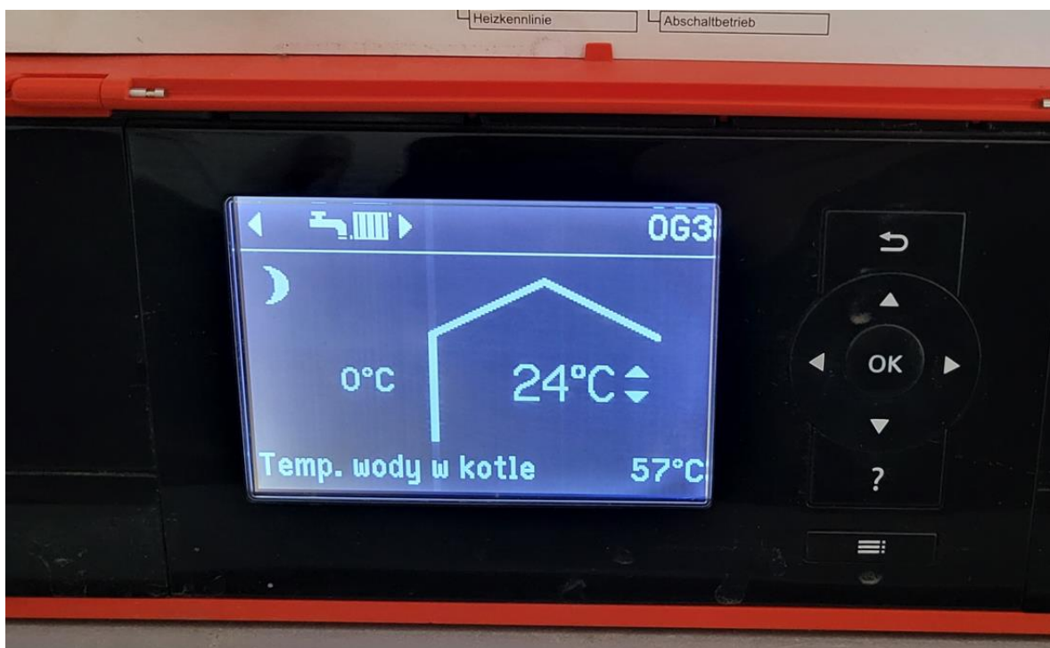
Fot. nr 7 Widok panelu sterowniczego Vltotronic 200. Źródło własne.
