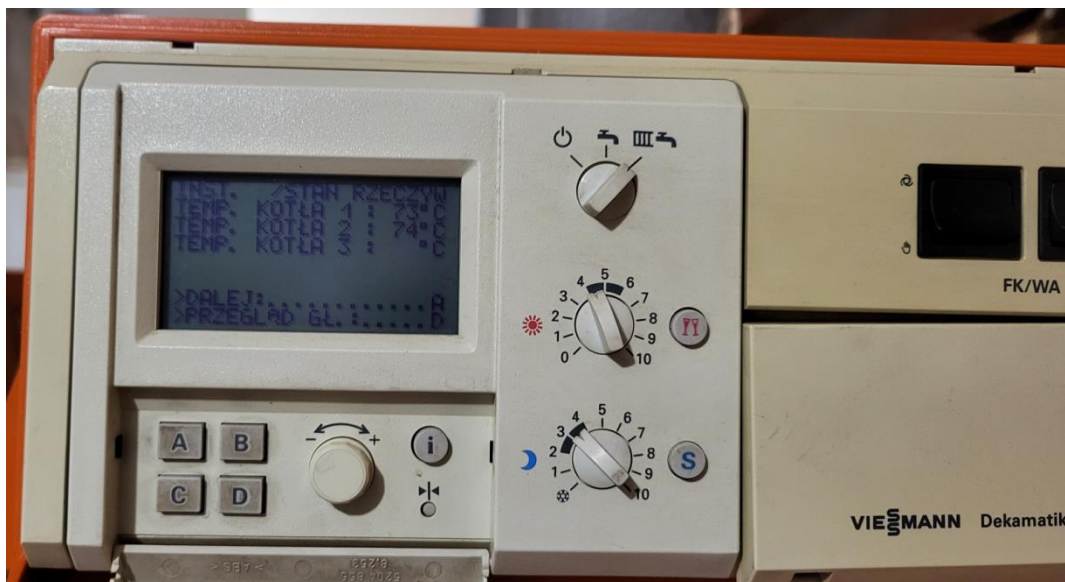
Fot. nr 14 Widok regulatora kotłowego Dekamatik. Źródło własne.
