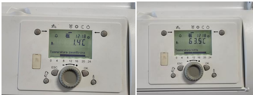
Fot. nr 2,3 Panel sterowniczy kotła nr 1. Źródło własne.
