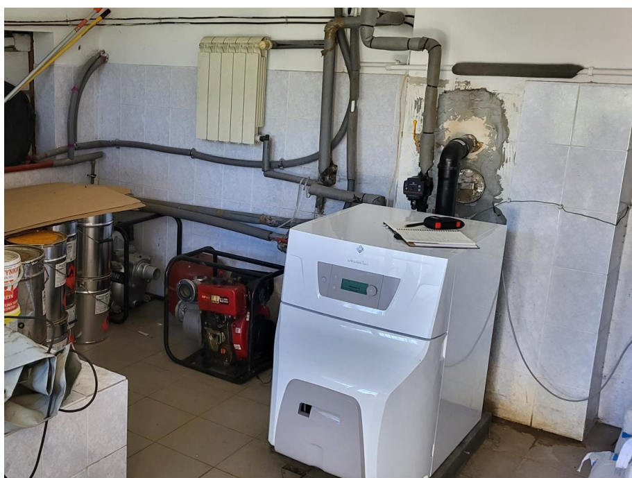
Fot. nr 4 widok kotła grzewczego wraz z instalacją. Źródło własne
