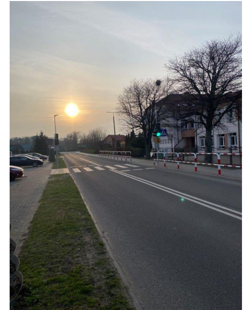
Zdjęcie 8. Budowa przejścia dla pieszych na drodze powiatowej nr 2918 C w m. Baruchowo.
