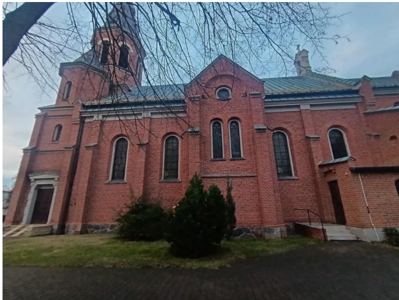
Zdjęcie 10. Remont konserwatorski ścian kościoła parafialnego pw. Wniebowzięcia NMP w Izbicy Kujawskiej – etap IX
